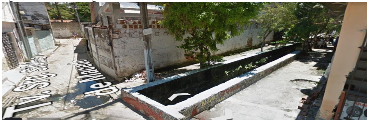
Figura 08. Canal de drenagem ZEIS Aritana
