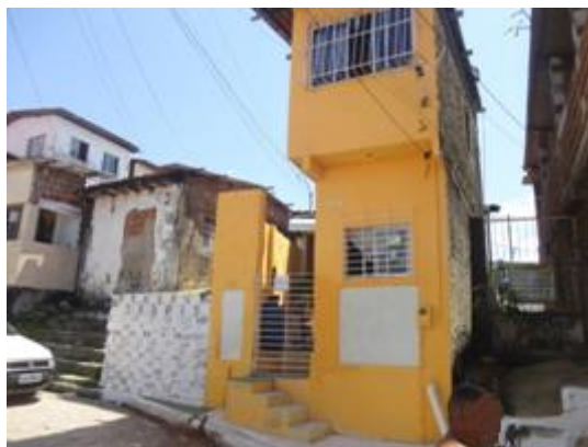
Imagem1: Habitação com pavimento superior extrapolando o limite do lote.
