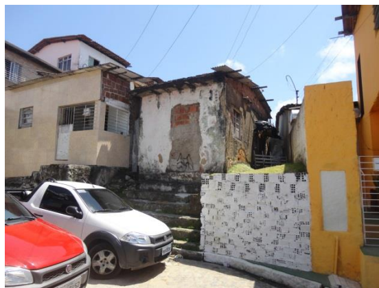
Imagem 2: Habitações conjugadas, com acesso precário e ventilação e iluminação insuficientes.
