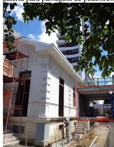
Figura 49: Anexo da fachada esquerda que será mantido em forma galeria para passagem de pedestres.
