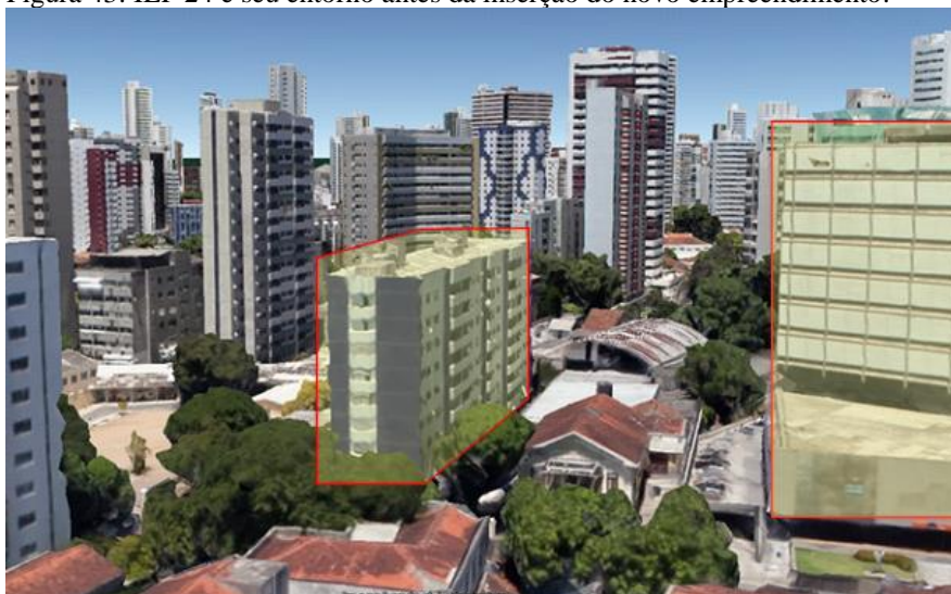
Figura 43: IEP 24 e seu entorno antes da inserção do novo empreendimento.
