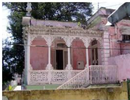
Figura 13: Imóvel N° 1509 constituente do conjunto de três unidades que formam o antigo Instituto Psiquiátrico do Recife na Avenida conde da Boa Vista.
