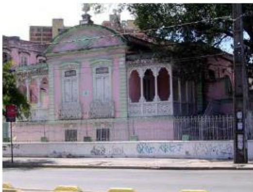
Figura 12: Imóvel N° 1509 constituente do conjunto de três unidades que formam o antigo Instituto Psiquiátrico do Recife na Avenida conde da Boa Vista.
