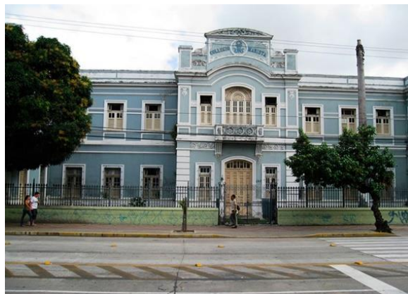
Figura 20: Antigo Colégio Marista, Avenida Conde da Boa Vista, 385, Boa Vista.
