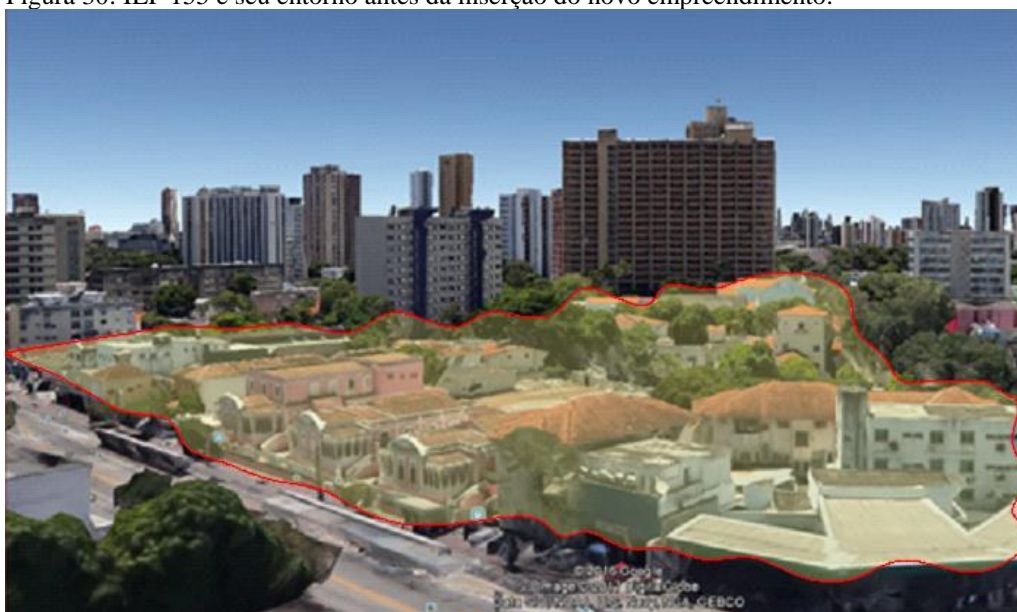
Figura 30: IEP 155 e seu entorno antes da inserção do novo empreendimento.
