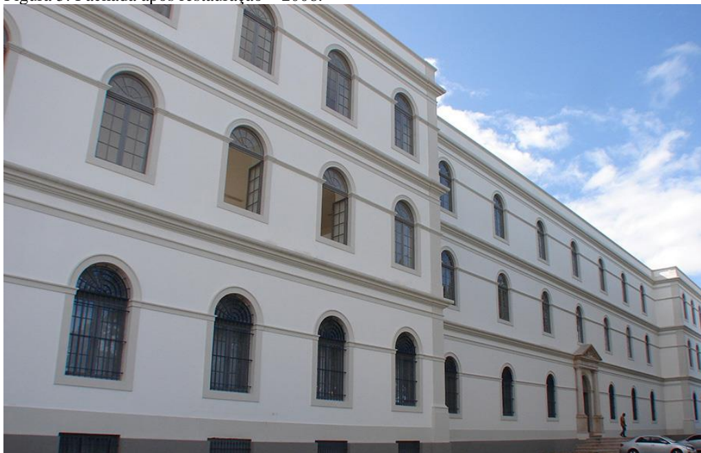
Figura 5: Fachada após restauração – 2008.
