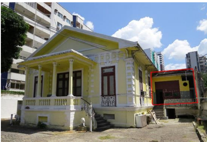
Figura 48: Anexo já existente na fachada esquerda do IEP 24.
