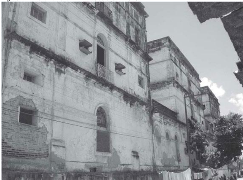
Figura 4: Fachada lateral antes da restauração – 2008.
