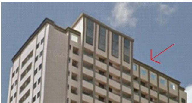
Figura 40: Coroamento do novo edifício.
